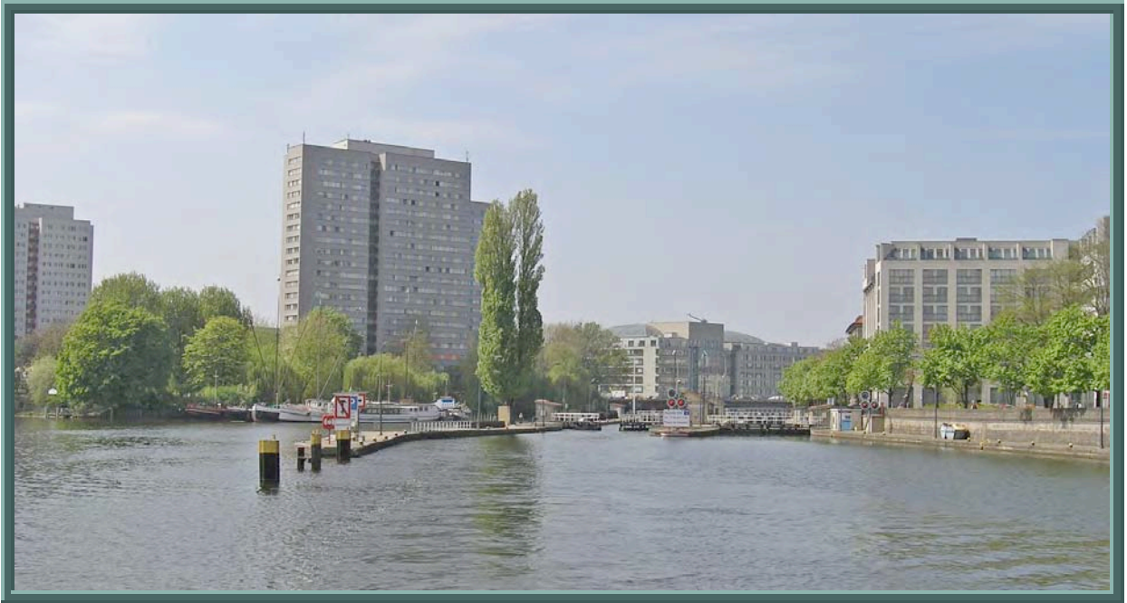
Schleuse Mühlendamm – Berlin Spree-Oder-Wasserstrasse (SOW) km 18,0 Blick auf das Obertor. Die roten Lichtsignale zeigen an, dass die Einfahrt in die Schleuse noch nicht erlaubt ist.
